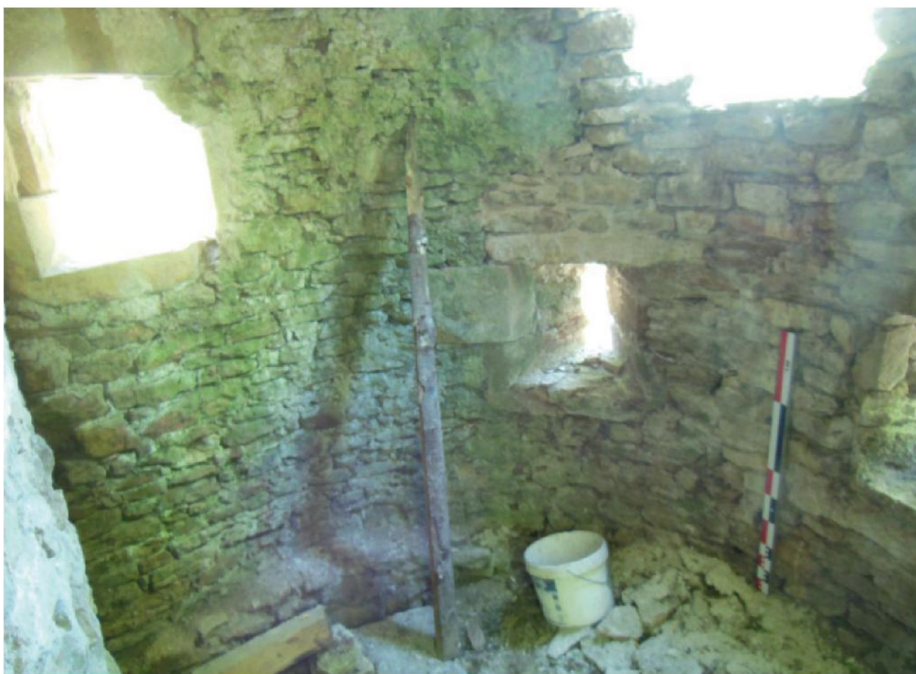
Fig. 10 : intérieur de la tourelle après restauration. La base et le montant gauche des canonnières du centre et de gauche sont en place. On remarque la position de la canonnière de gauche, plus haute que les trois autres
