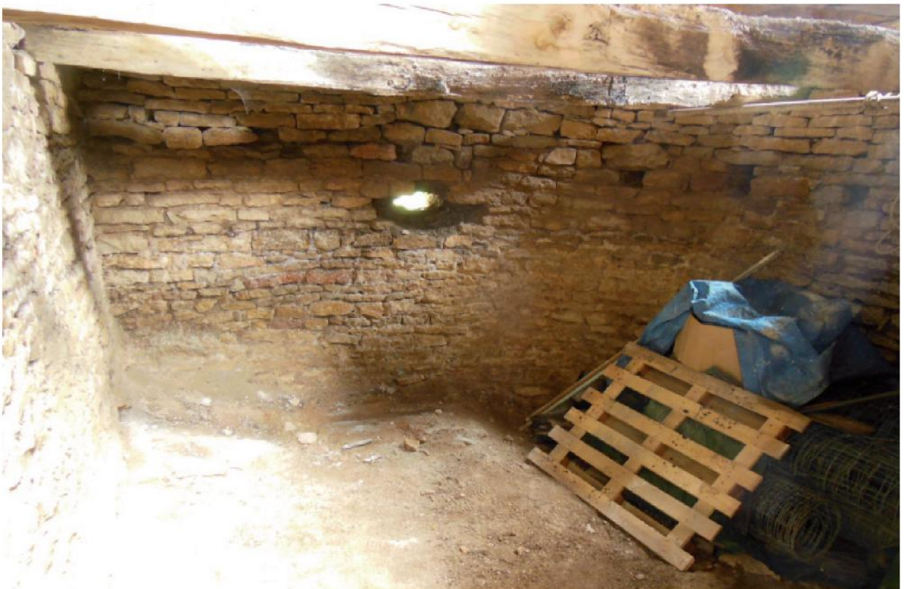
Fig. 21 : tour du jeu de Paume, premier étage de soubassement, état après nettoyage en 2018.
