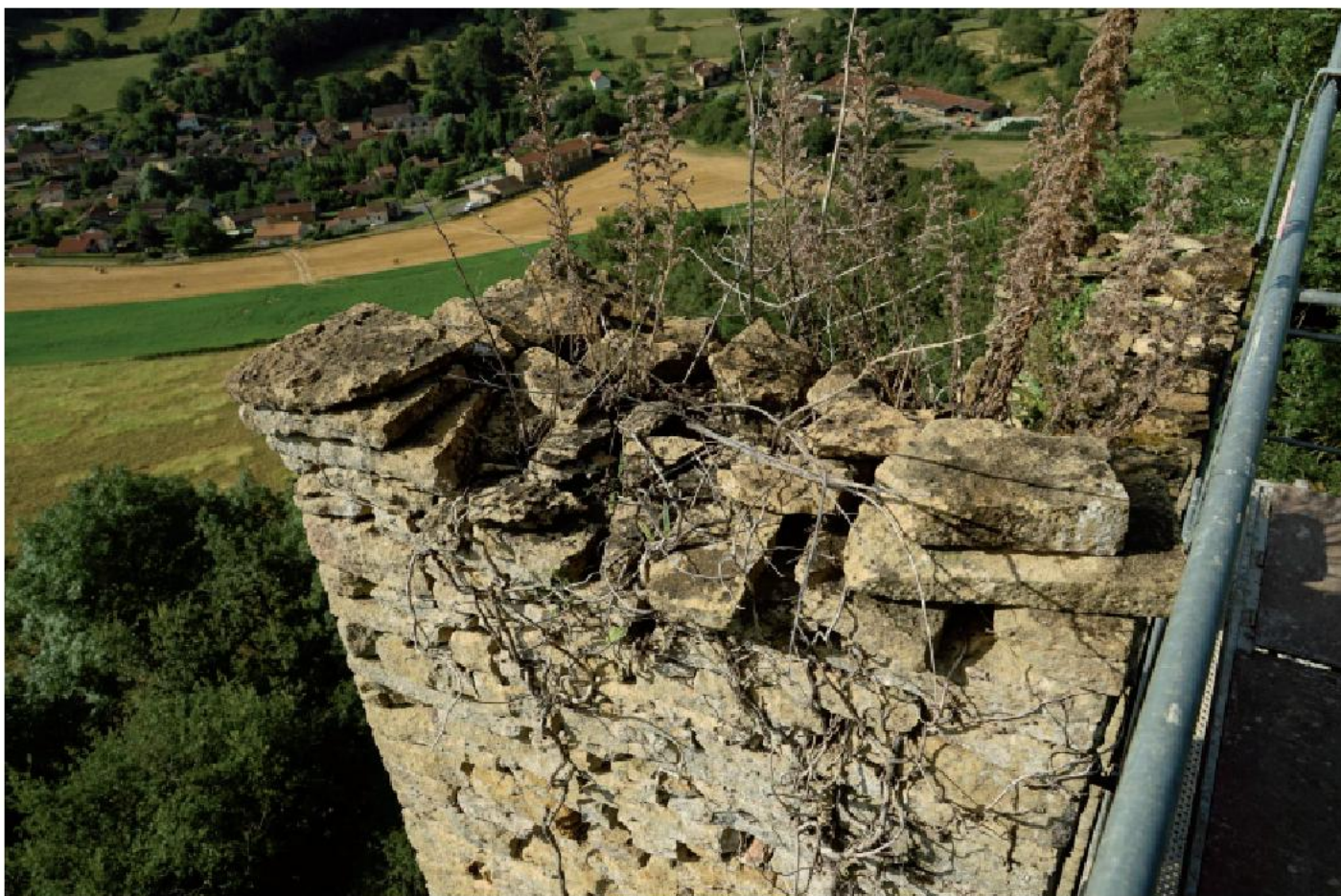
Fig. 35 : sommet de la pile n° 9.
