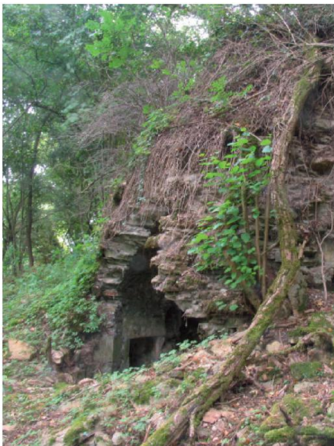
Fig. 3 : état avant travaux (août 2012).
