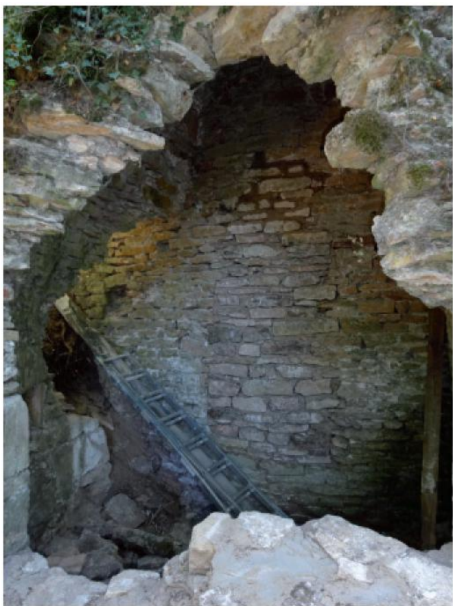
Fig. 5 : premiers travaux : restauration de l'angle du mur de courtine, à l'intérieur de la tourelle (août 2017)
