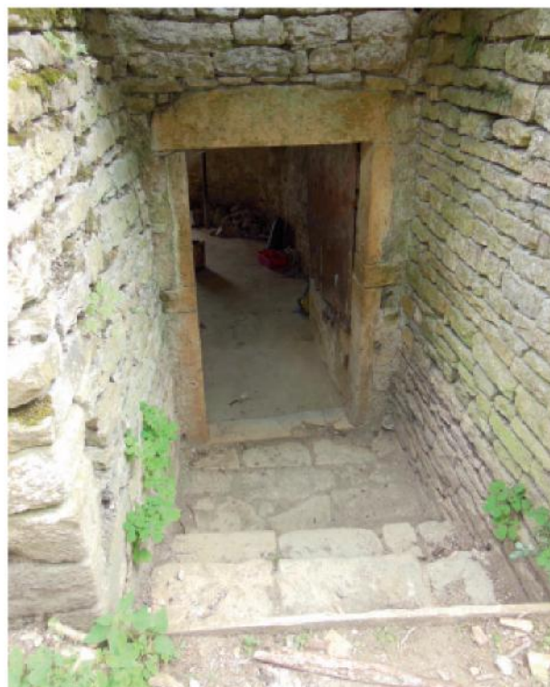
Fig. 24 : entrée du rez-de-chaussée, 2018.
