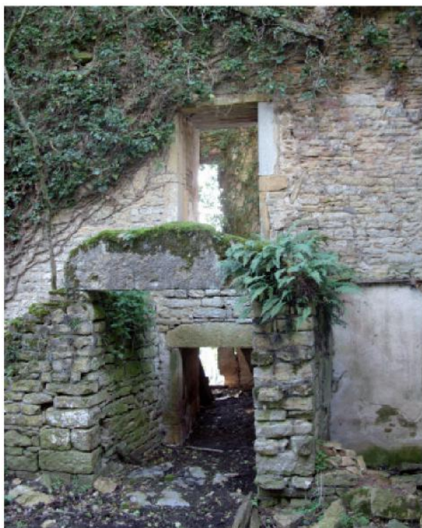
Fig. 23 : entrée du rez-de-chaussée, 2012.
