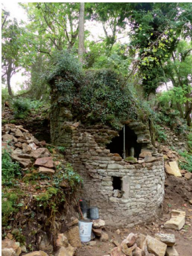
Fig. 6 : tourelle en cours de travaux (septembre 2017)
