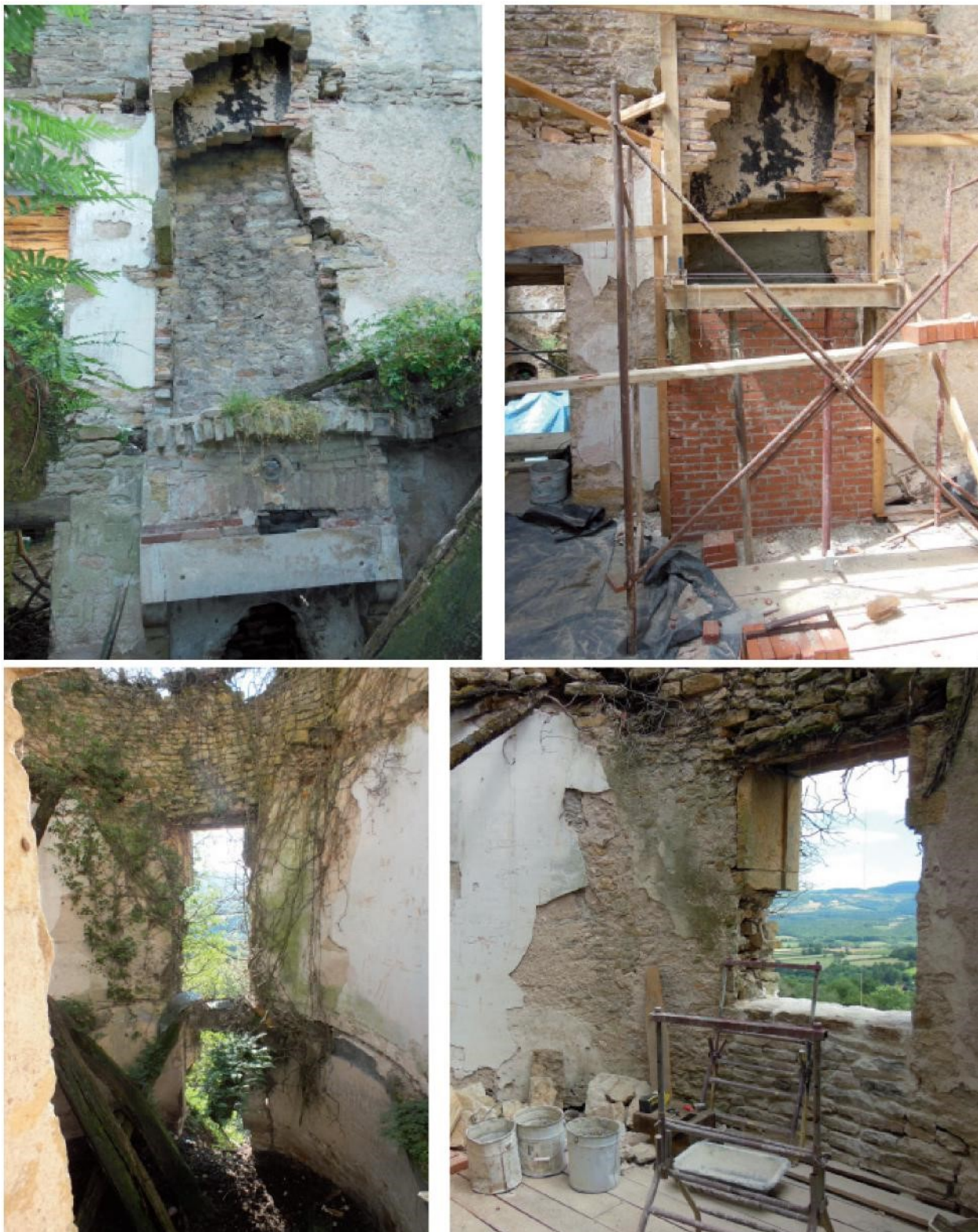
Fig. 28 à 31 : premier étage avant restauration (à gauche) et après (à droite).
