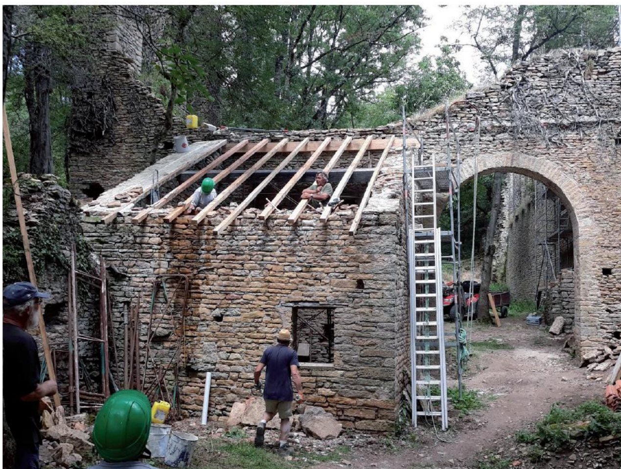
Fig. 17 : petite écurie, pose du toit, juillet 2018.
