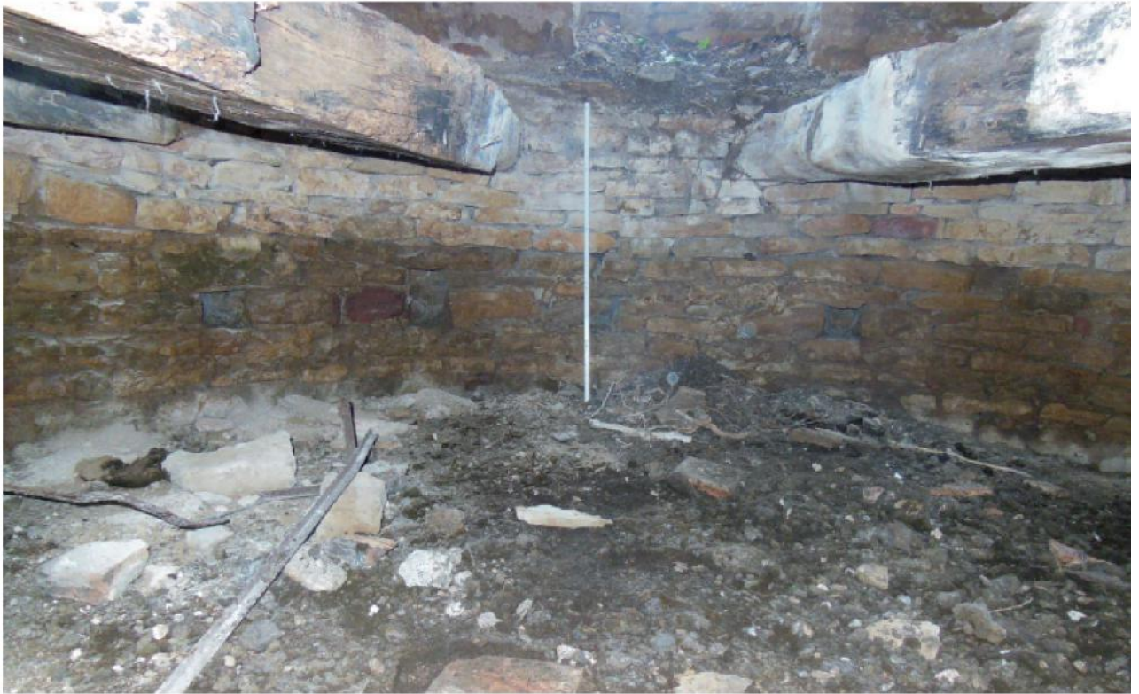
Fig. 20 : tour du jeu de Paume, premier étage de soubassement, état en 2012.
