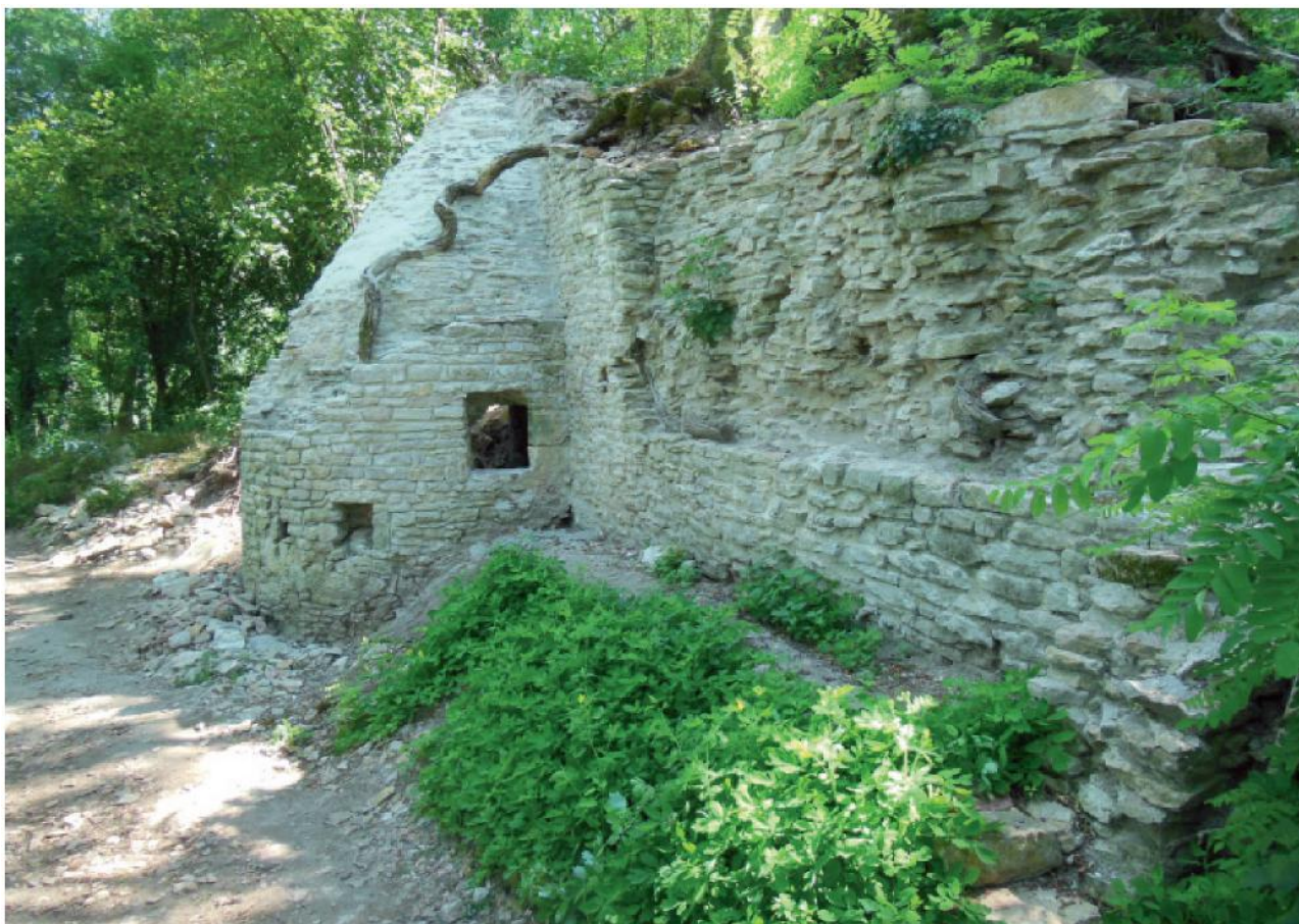
Fig. 9 : tourelle restaurée, vue du nord. La « fenêtre » rectangulaire est composée d'une demie-canonnière (à droite) et d'un montant d'attente (à gauche).
