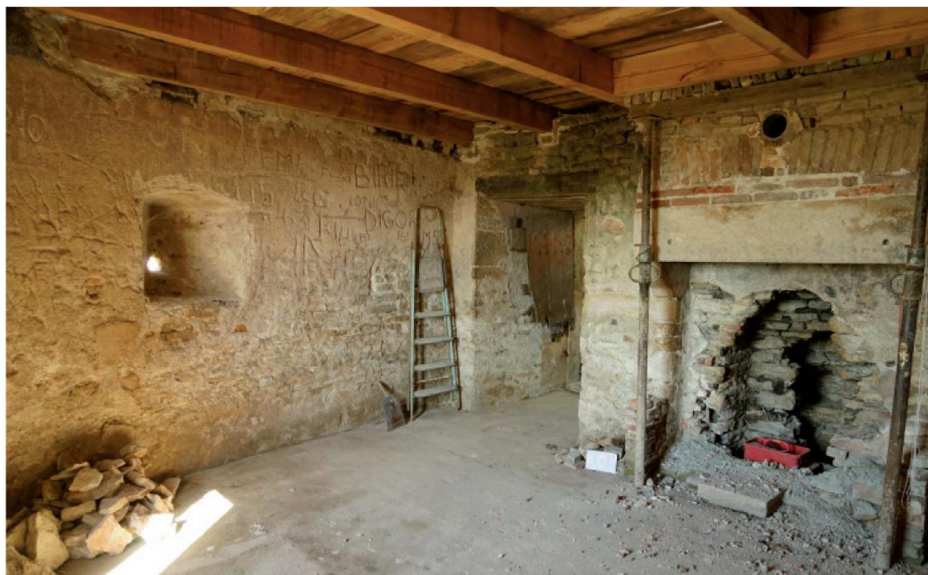
Fig. 25 à 27 : rez-de-chaussée avant restauration (en haut) et après (en bas).
