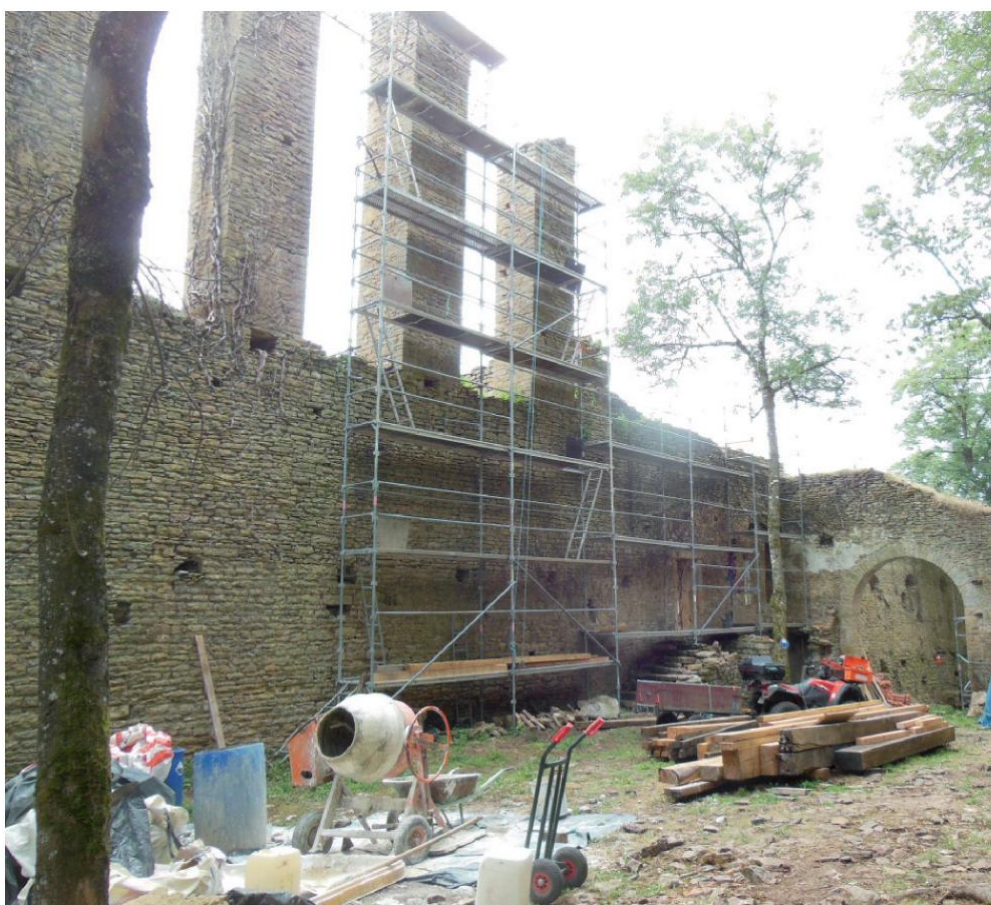
Fig. 32 : échafaudage devant les piles 9 et 10 du jeu de Paume.
